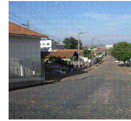
RUA NOSSA SENHORA DE FÁTIMA - TRECHO 1
