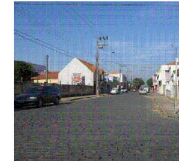
RUA NOSSA SENHORA DE FÁTIMA - TRECHO 4
