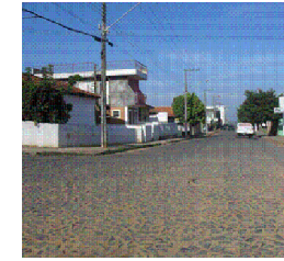
RUA NOSSA SENHORA DE FÁTIMA - TRECHO 2
